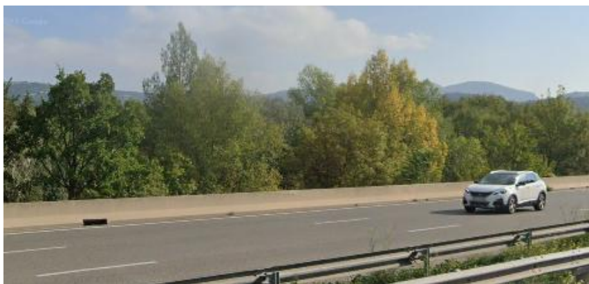
L'autoroute surplombe en partie le site
